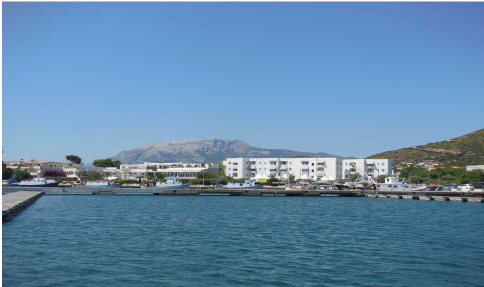
La Caletta, pannes en construction
