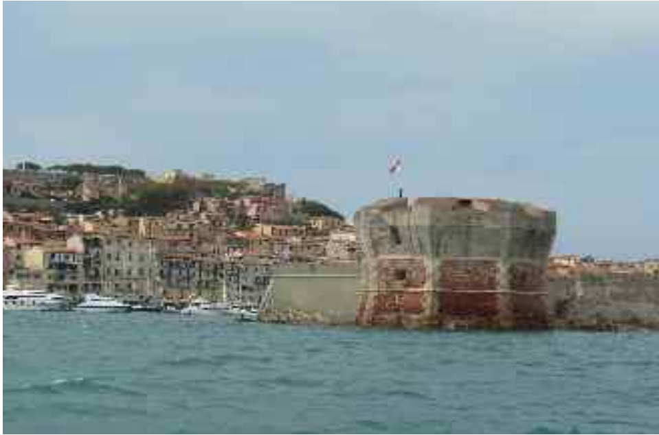
Entrée du port de Porto Ferraio
