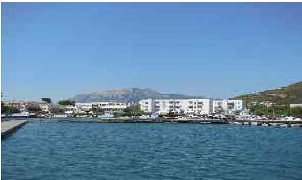
La Caletta, pannes en construction
