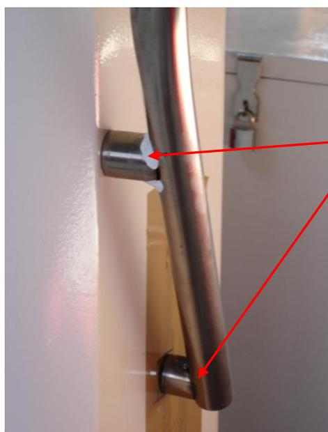
Les entretoises sont positionnées provisoirement sur la main courante et maintenues en place avec de la patte ' Répar express ' afin qu'elles ne bougent pas en attendant le cordon de soudure.
